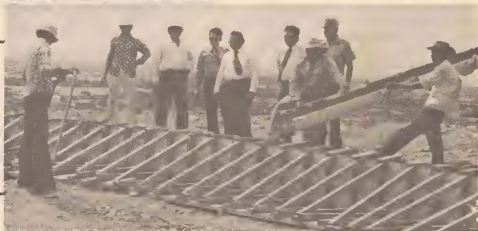
Comienso di construccion di un tanki di awa na Jaburibari, pa mehora e servicio di awa pa e bario nan, Jaburibari, Papaya, Calabas y un parti di Paradera.
